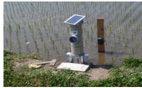
写真1：スマート田んぼダム 自動排水栓
